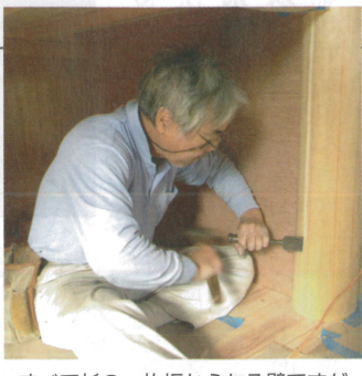
すべて杉の一枚板からなる壁ですが天井はまだ鉄骨がむき出し
