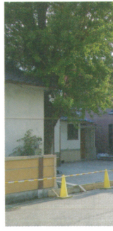
北門 北塀撤去後
