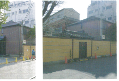
北門 北塀撤去前
