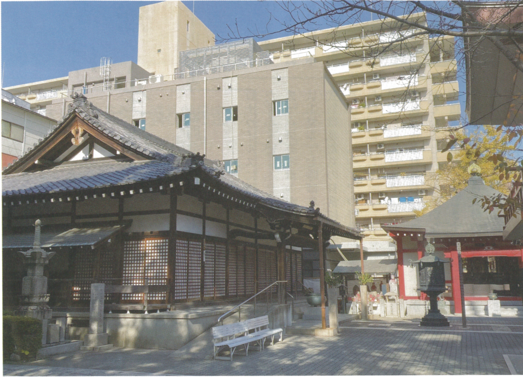
まもなく竣工の講堂を境内より望む
